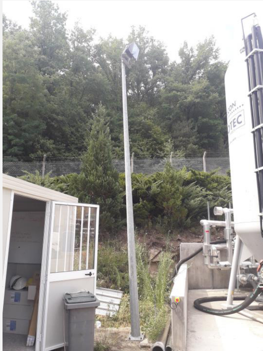
Retrait du poteau éclairage HS menaçant de tomber
