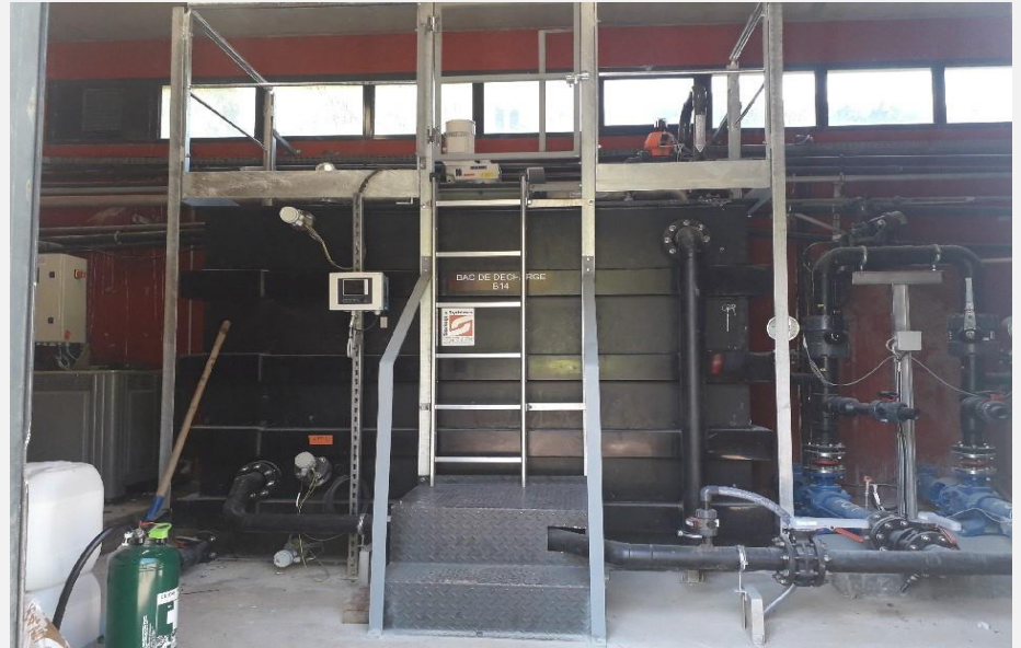
Accès Bac de décharge
