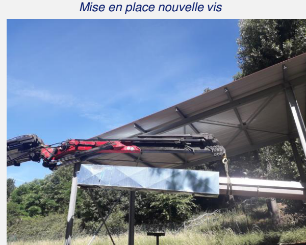
Mise en place nouvelle vis
